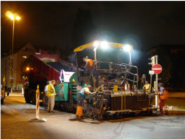
Niedrigtemperatur-Asphalt im Nachteinbau
