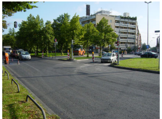
Der Morgen danach: Eine homogene und ebene Oberfläche als Ausgangspunkt für die Asphaltdeckschicht
